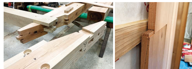
左：「常に新しいことにトライしたい」と考える沖本さんは、仕口や継手も伝統に甘んじることなく独自に進化させている 右：大工がフィンガージョイント加工を施した壁板。年月を経ても美しさを損なわないようにするための大工ならではの仕事だ
